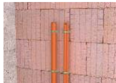
Вертикальная прокладка отдельного кабеля или пучка кабелей на стене
