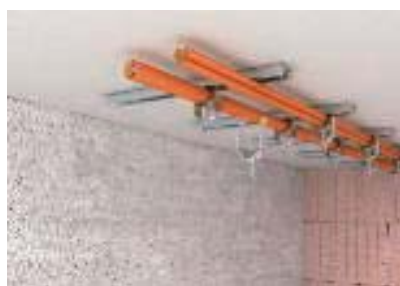
Монтаж отдельного кабеля или пучка кабелей
