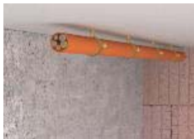
Монтаж под потолком
