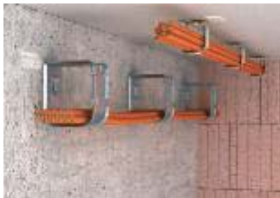
Горизонтальный настенный и потолочный монтаж
