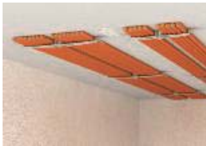
Компактная прокладка кабелей непосредственно под потолком
