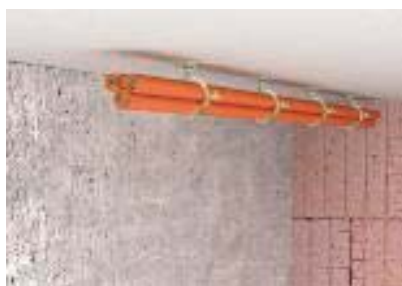
Пучки проложенных под потолком кабелей
