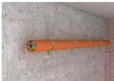
Горизонтальный настенный монтаж кабеля
