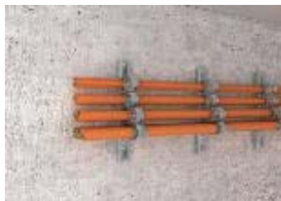
Горизонтальный монтаж кабеля зажимными скобами на стене
