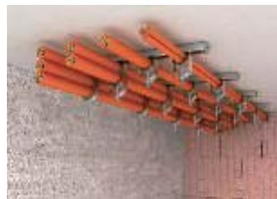
Горизонтальный монтаж кабеля зажимными скобами под потолком
