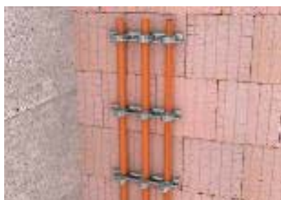
Вертикальный монтаж кабеля зажимными скобами на стене
